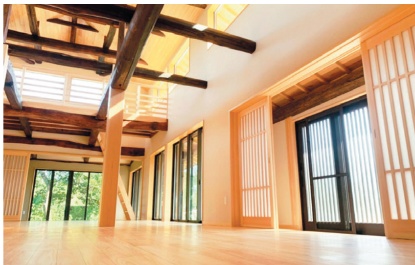
当時の梁や柱の木造軸組を残したまま吹き抜けとして元の古い丸太を活かし、目立たせるよう施工
