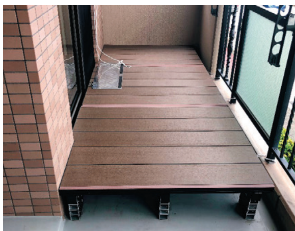
バルコニーに出られるよう段差解消
